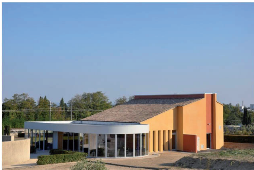
Crématorium de Bourg-Saint-Andéol
