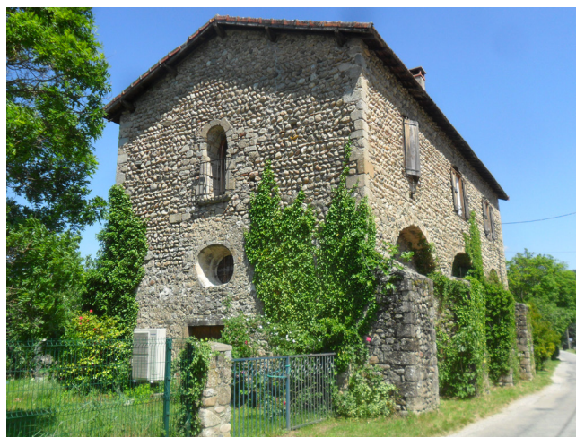
L'église de Royas. La présence d'arcs de décharge latéraux semble liée à un rehaussement récent
